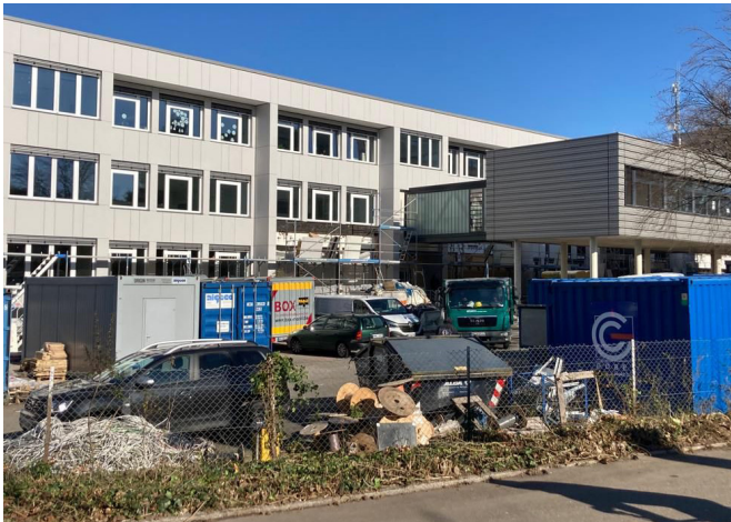
Wo Baustelle ist, sind vermutlich auch PFAS. Foto: Cornelius Krähler
