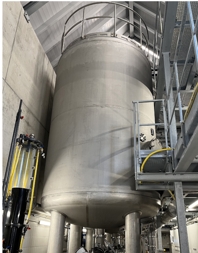
Aktivkohlefilter im Wasserwerk Rauental. Foto: Hannah Adam
