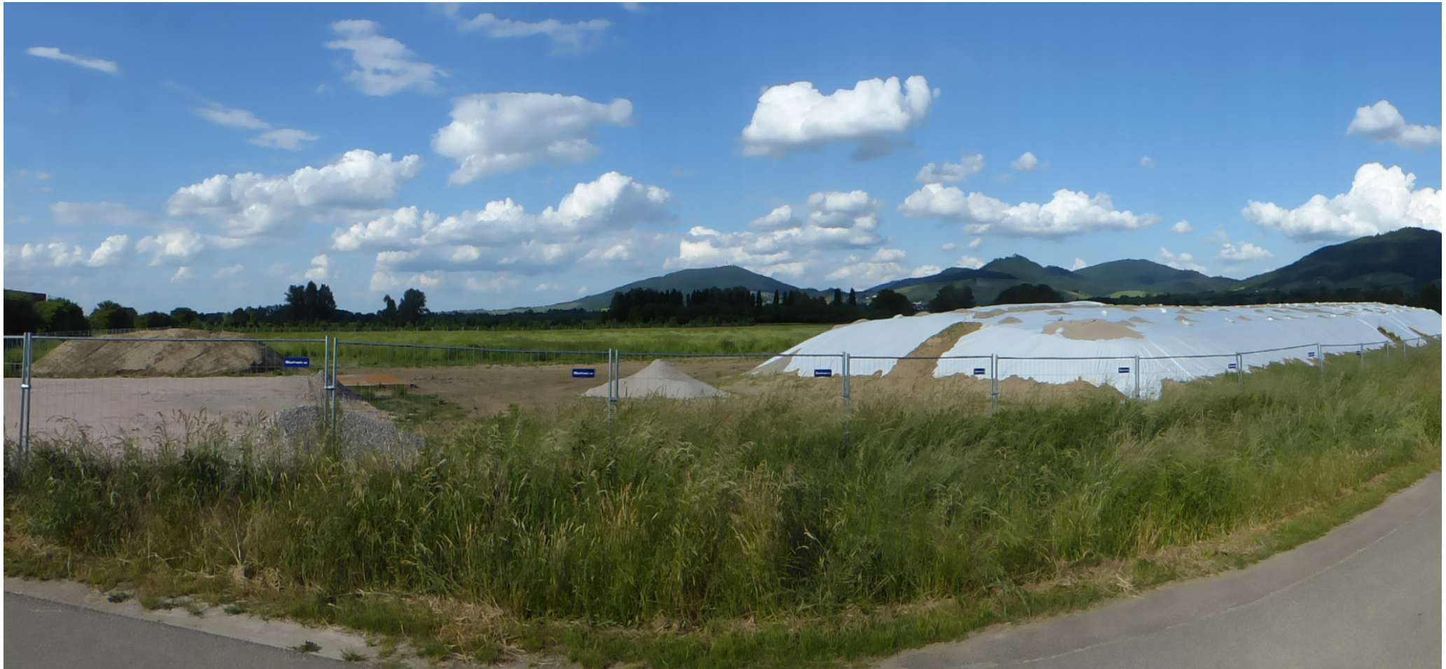
Die belastete Erde wird zuerst zwischengelagert, um dann in dem Gebiet der Bußmatten eingebaut zu werden. (Foto: ©Patricia Klatt)
